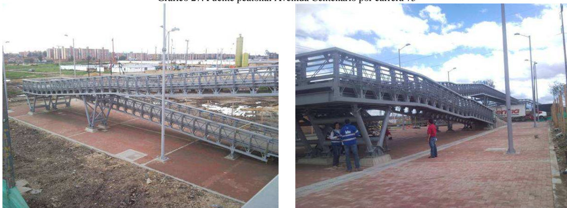
Gráfico 27. Puente peatonal Avenida Centenario por carrera 75
