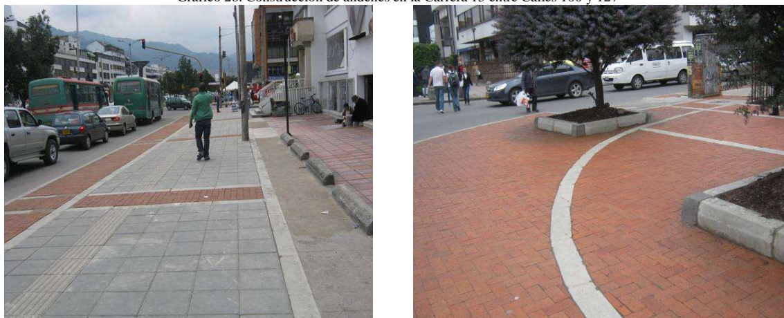
Gráfico 26. Construcción de andenes en la Carrera 15 entre Calles 100 y 127
